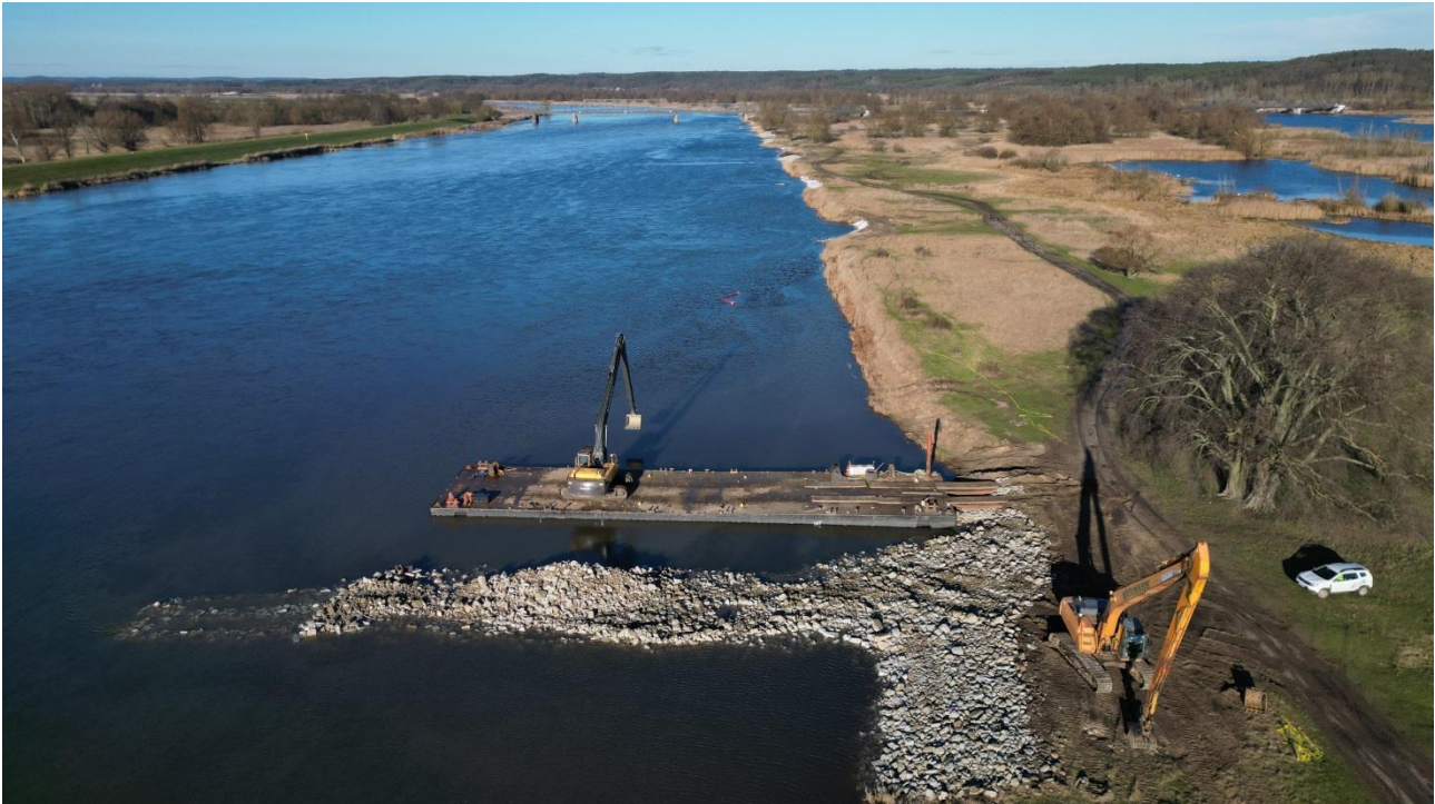
Ryc. Budowa ostróg przy użytku ekologicznym Kostrzyneckie Rozlewiska, w lutym 2023r., obecnie Rezerwat Gęsi Bastion), fot. Anna Grebieniow.
