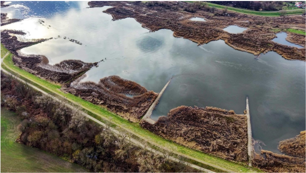
Ryc. Odra w okolicy Górzycy - ostrogi (główki) o dł. 100 metrów sięgają prawie środka rzeki, wyraźnie widać zarastanie i lądowanie rzeki (fot. Fabian Storożak)
